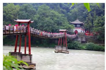
都江堰_安瀾索橋
