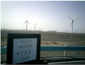
風力発電設備
